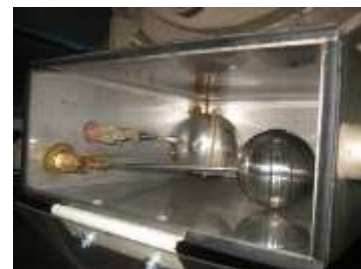
Gambar 10. Penempatan Pelampung Lama Dan Baru (Tambahan) Di Feed Water Tank . (tampak atas)
