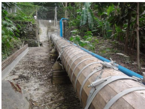
Gambar 3. : Pipa pesat ( Penstock ) terbuat dari kayu jati dengan diameter dalam 510 mm dan panjang 30 m.
