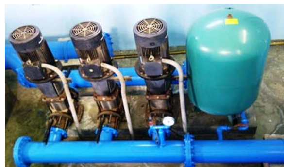
Gambar 2. Tiga unit pompa paralel
