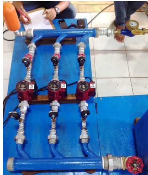
Gambar 5. Pompa paralel dengan header 2"
