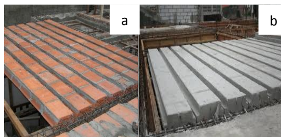
Gambar 1. a. Balok Material Keramik Komposit b. Balok Berpori
