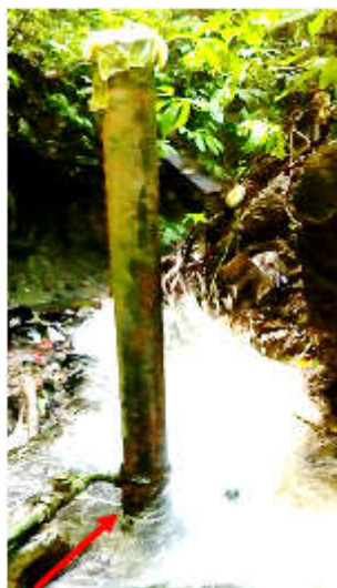
Gambar 2. Lubang snifter-valve pada pompa hydram
