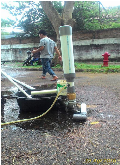
Gambar6. Hasil pembuatan dan perakitan pompa hydraulic ram pump
