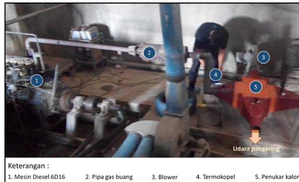
Gambar 3. Instalasi peralatan pengujian penukar kalor.
