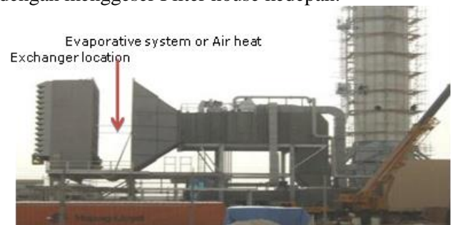
Gambar 5 Penempatan Evaporator dalam saluran intake GT
