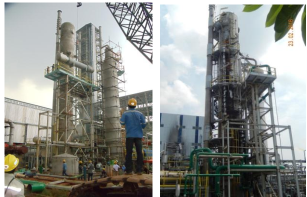
Gambar 4. Fasa Konstruksi dan Erection
