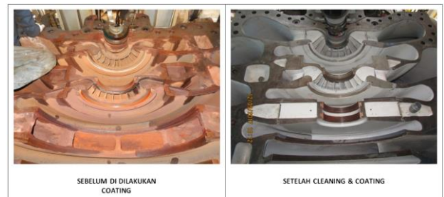
Gambar 8. Coating Casing Bagian Dalam Rotor
