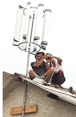
Gambar 12. Pemasangan turbin pada rumah sederhana
