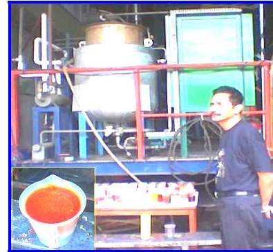
Gambar 2 : Biodiesel Plant Puspitek BPPT
