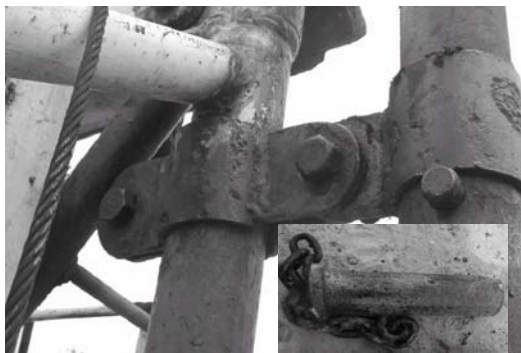
Gambar 8. karat pada sambungan (pin - sleeve)
