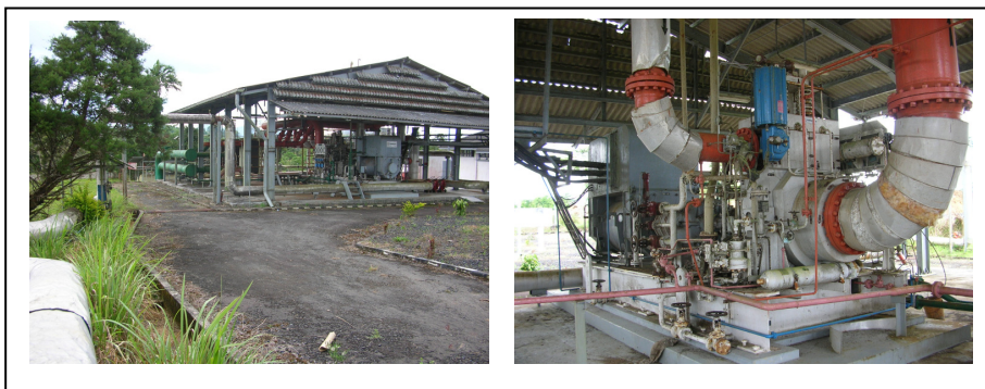
Gambar 4. Pembangkit listrik siklus biner 2,5 MW, Pangolombian, Sulut.
