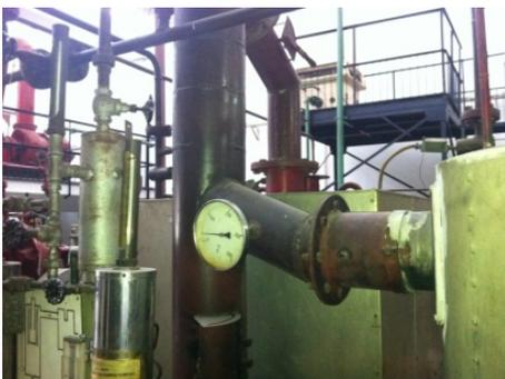
Gambar 2. Termometer pada mesin boiler di Laboratorium Energi Termal FTMD ITB
