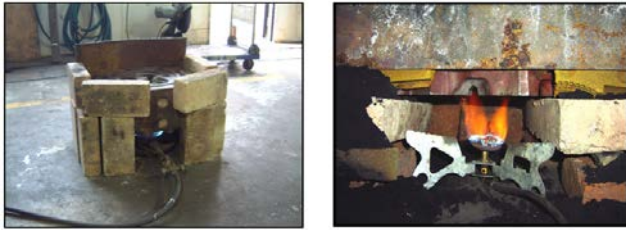
Gambar 13. Pemberian preheat dengan menggunakan kompor. Sekeliling komponen ditutupi bata tahan api.
