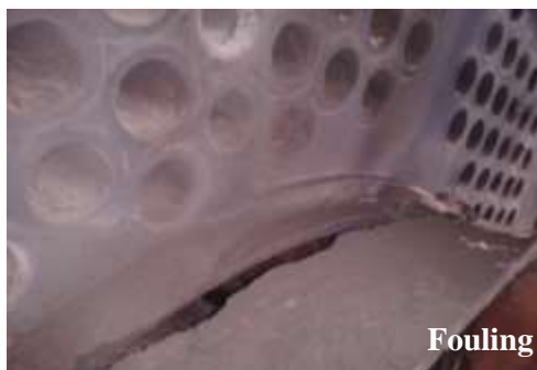
Gambar 4. kondisi ketel uap sebelum dibersihkan menggunakan bahan bakar batubara lignit
