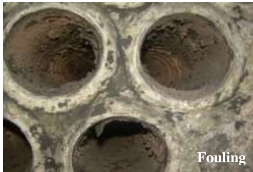
Gambar 3. kondisi ketel uap sebelum dibersihkan menggunakan bahan bakar campuran 60% batubara lignit dan 40% cangkang biji jambu mete
