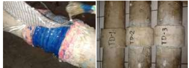
Gambar 9 Proses lay-up kopler dan Sambungan yang telah selesai
