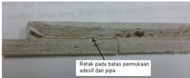
Gambar 21 Mode kegagalan spesimen p-3 yang mendapat beban tekanan internal.
