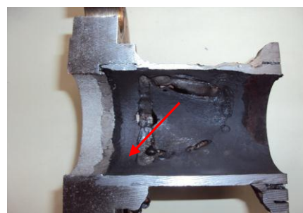
Gambar 9. Anak panah menunjukkan retak tembus dan retak halus pada daerah HAZ pada bagian dalam dari pipa.
