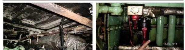
Gambar 5. Area di atas mesin induk kiri yang kerusakan (kiri). Adanya kebocoran pada pipa bahan bakar tekanan tinggi pada pompa bahan bakar silinder nomer 1 (kanan)
