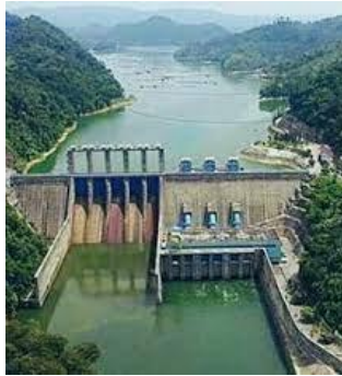
Gambar 1. Spillway Gate (Kiri) dan Tailrace Gate (Kanan)
